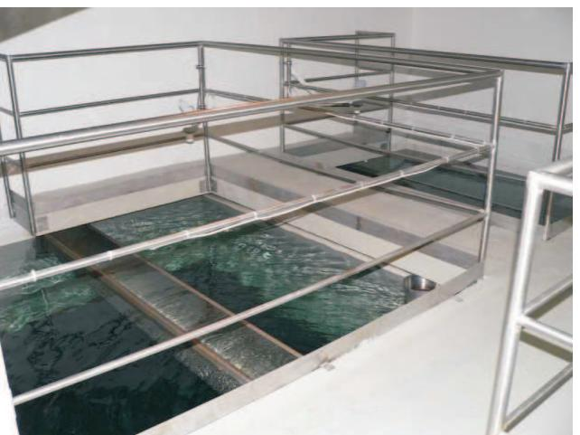
Alkalizace vody je prováděna filtrací na dvou filtroch s náplní polovypáleného dolomitu (PVD). Náplň PVD (skladovaný v pytlech) je do filtrov doprováděna pomocí trojice spirálových dopravníků. Využití filtrov je odvislé od skutečné kyselosti vody a o provozu rozhoduje řídící systém ÚV dle údajů analyzátoru, proto je možné oba filtrov obtokovat.
