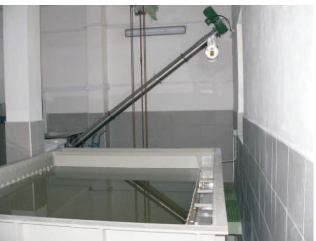
Úprava senzorických vlastností filtrátu probíhá na dvou otevřených filtroch s filtrační náplní granulovaného aktivního uhlí (GAU). O využití a počtu provozních filtrov rozhoduje řídící systém, který řídí provoz i praní filtrov. Oba filtry je možné obtokovat. Praní filtrov je prováděno akumulovanou pitnou vodou a vzduchem. Prací čerpadla a dmychadlo jsou společné pro filtry GAU i PVD. Prací vody z filtrov GAU i PVD jsou akumulovány a znova využívány k úpravě.
