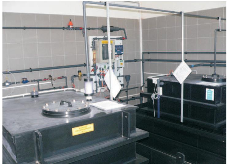
Stávající akumulace ÚV je rozdělena na dvě samostatné části, umožňující odstavení a čištění jedné z nádrží. Z akumulace ÚV je voda čerpána vždy dvojicí čerpadel na distribuční vodojem - na VDJ Kozinec 3 x 660 m<sup>3</sup> se čerpá  $Q = 30 \text{ l.s}^{-1}$ , do VDJ Skanzen II 2 x 1000 m<sup>3</sup> je čerpáno  $Q = 15 \text{ l.s}^{-1}$ . Toto řešení zajišťuje optimální využití vydatnosti prameniště bez přetěžování.
